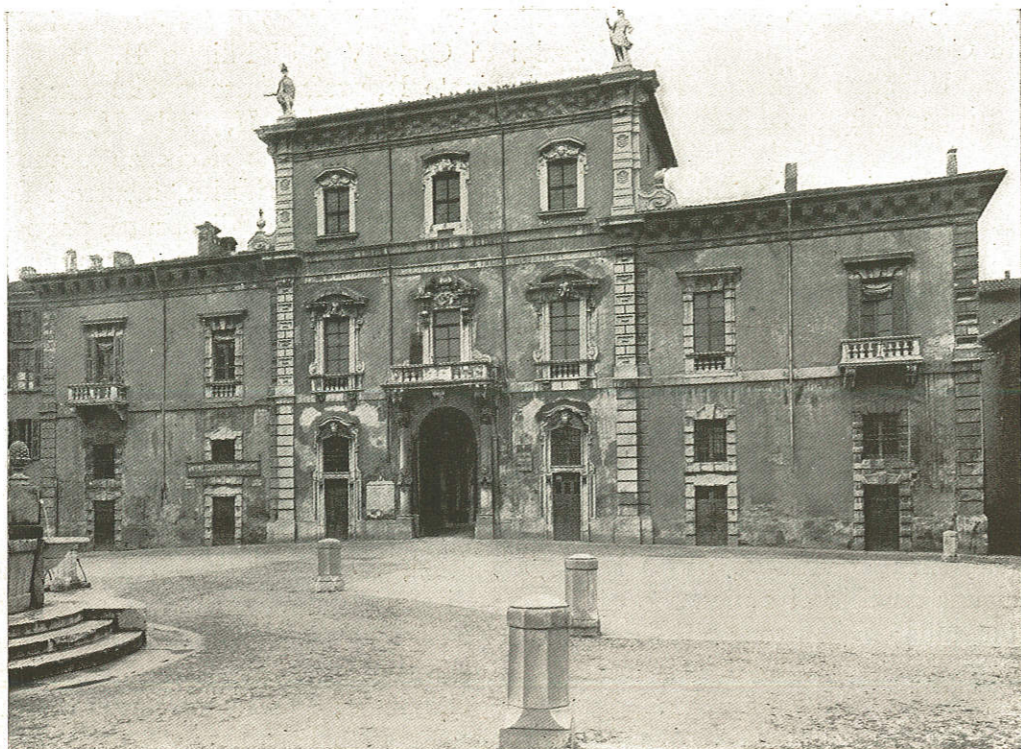
IL PALAZZO MARTINENGO PALATINI PRIMA DEI RESTAURI.
