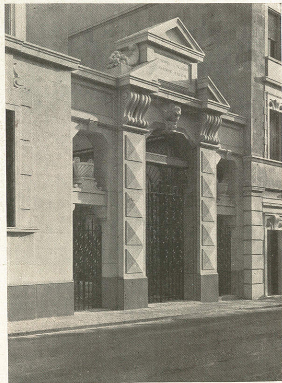
L'INGRESSO AL GIARDINO E AI SERVIZI MEDICI.
