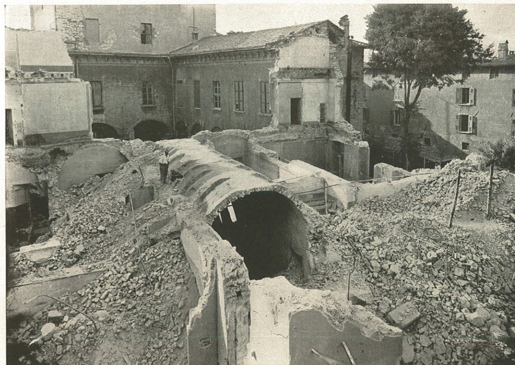
LAVORI DI DEMOLIZIONE DELLE VECCHIE CASE IN VIA FRATELLI PORCELLAGA.
