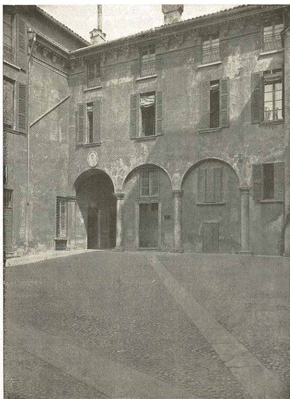
LATO DEL CORTILE PRIMA DEL RESTAURO.
