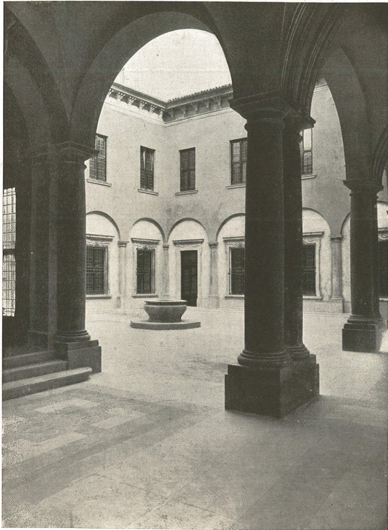
VEDUTA DEL CORTILE DOPO IL RIORDINAMENTO.
