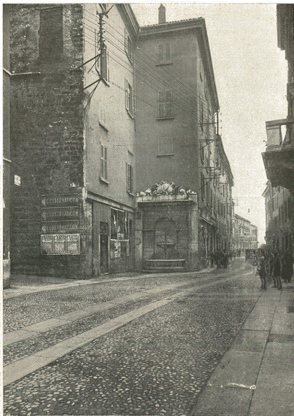
FACCIATA DEMOLITA DEL PALAZZO MARTINENGO PALATINI SULLA VIA PORCELLAGA - AVANZO DELLA TORRE TEOFILA.
