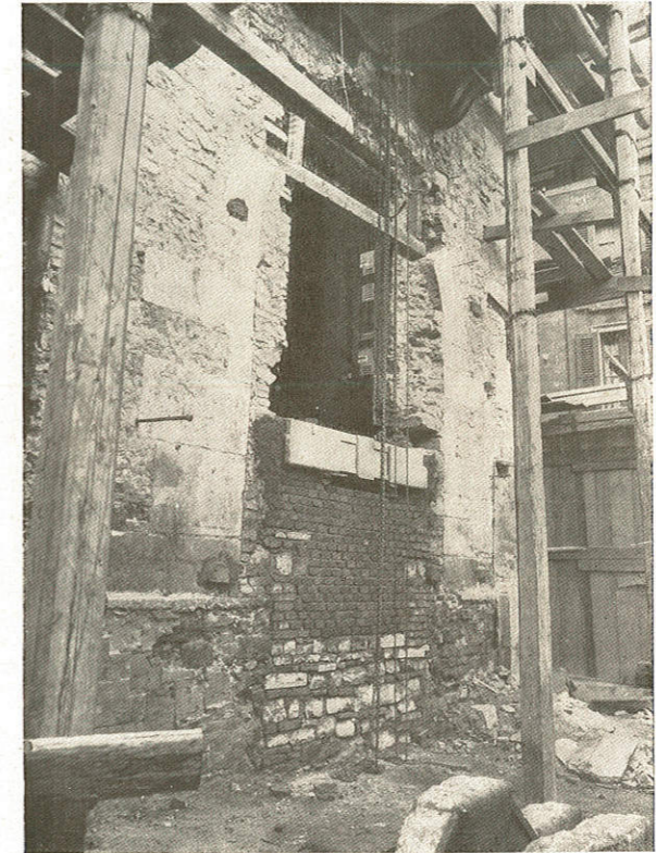
UNA FINESTRA VERSO LA PIAZZA DEL MERCATO DURANTE IL RESTAURO.
