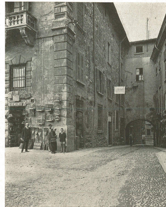
IL VICOLO DEGLI ASINI PRIMA DEI LAVORI DI COMPLETAMENTO.
