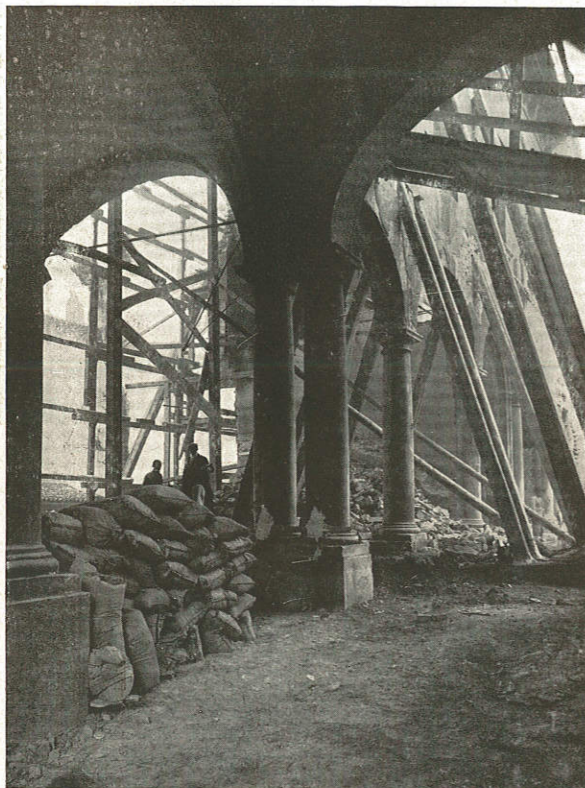
PORTICO E CORTILE DEL PALAZZO DURANTE I LAVORI DI RESTAURO.
